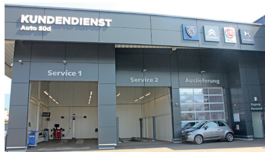
Komplette Prüf- und Kalibrierungsstraße von Kastner bei Auto Süd in Villach
