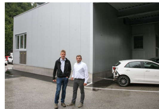
Die jüngste Betriebserweiterung stellt ein rund 100 m 2 großer Zubau dar, der die neue Lackierkabine und einen Lagerraum beherbergt
